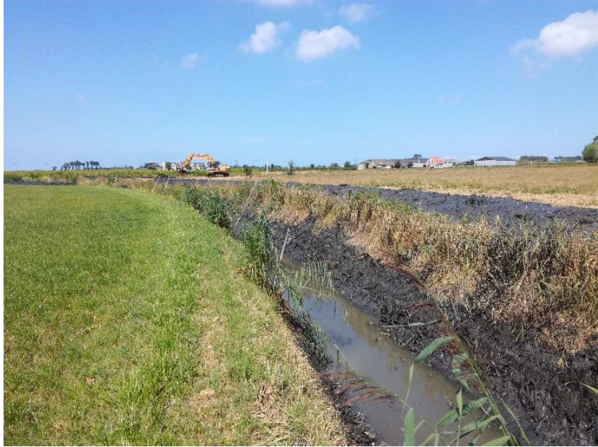
WH.8.6.1.3. tussen de Oostkerkestraat en de Krinkeldijk in Hoeke (Damme)
