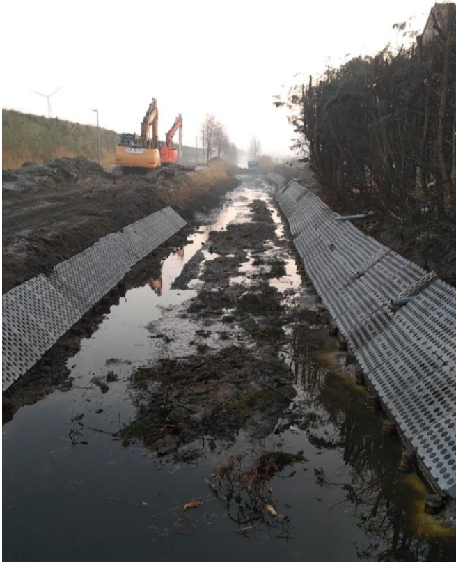
plaatsen oeverversterking Zijdelingse Vaart
