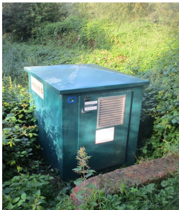
voormalige vijzelpomp t.h.v. sifon in Damme
