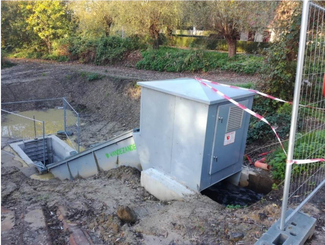
herstelde pomp t.h.v. sifon in Damme
