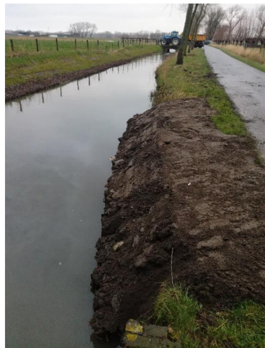
oeverherstel Ronselare met houten palen en keien, aangevuld met aarde
