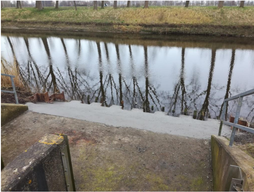
Herstelde uitstroombouwconstructie pompgemaal Ronselare
