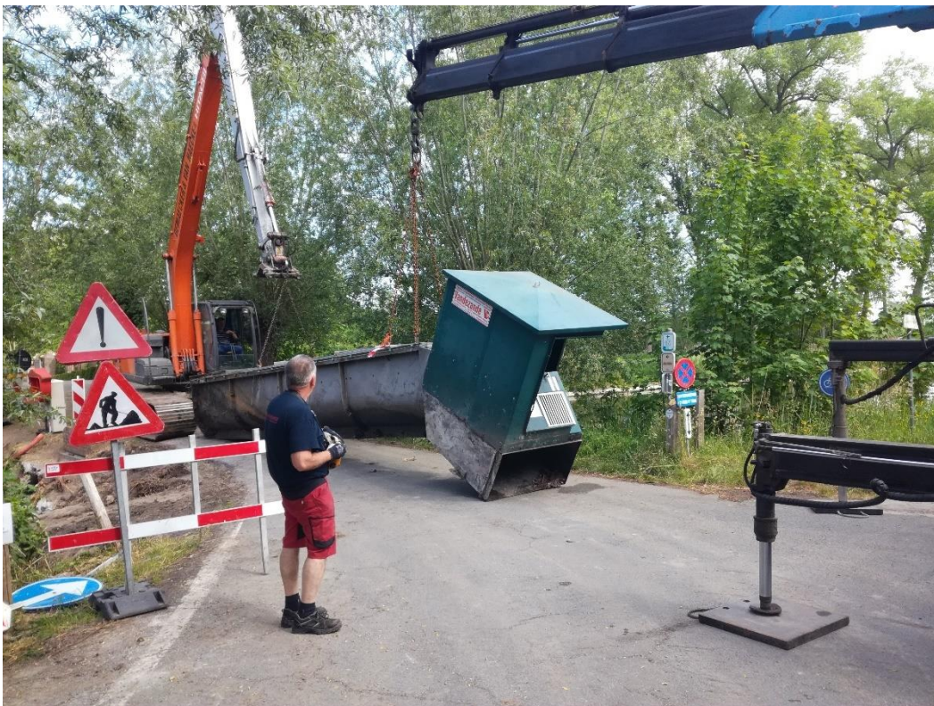
opbraak bestaande vijzel t.h.v. sifon in Damme
