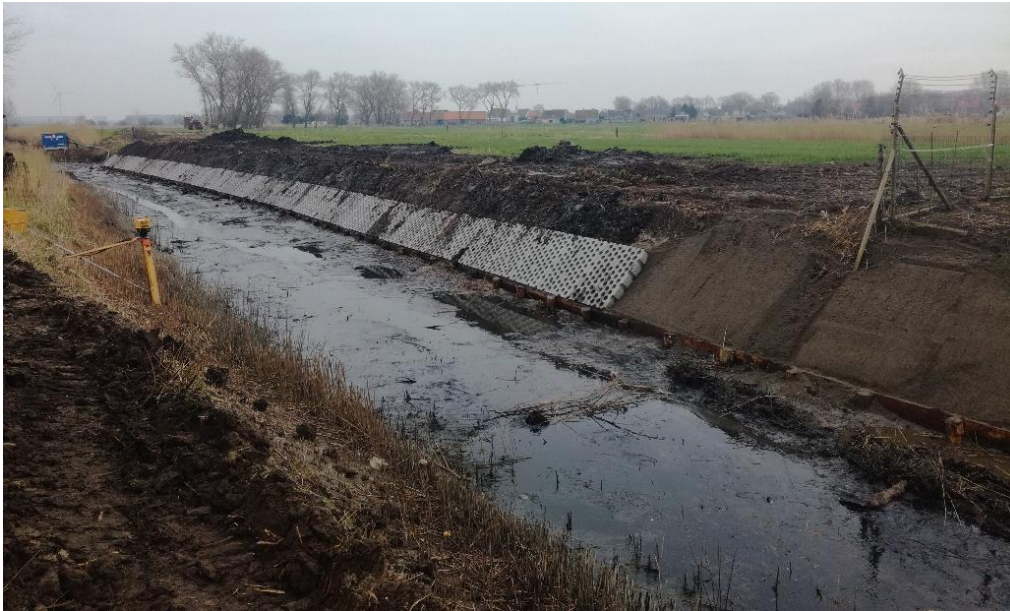
plaatsen oeverversterking Zijdelingse Vaart
