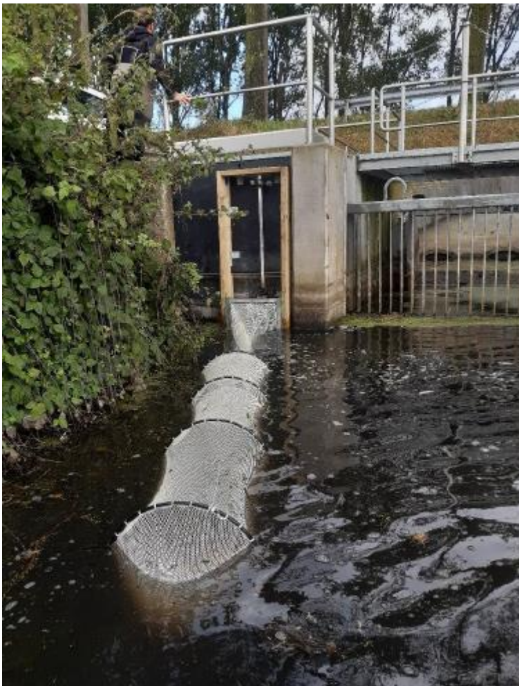
fuiikconstructie Geleed Zuid
