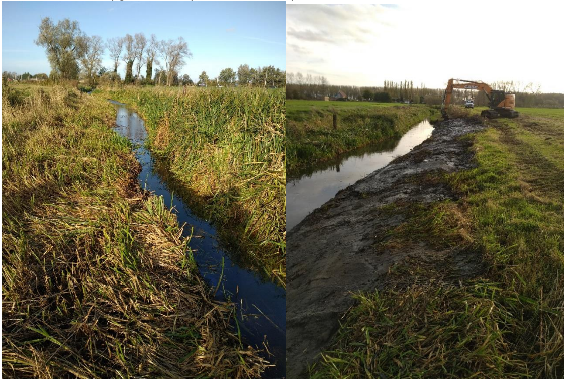
oeverherstel Verloren Kreek
